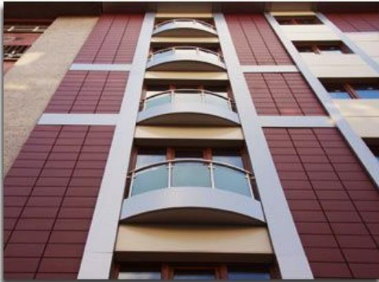
Наборной алюминиевый фасад COTTA имеет гораздо большую ударную прочность, чем у традиционного винилового и алюминиевого сайдинга, проще в монтаже, позволяет выполнять архитектурно более сложные элементы.
